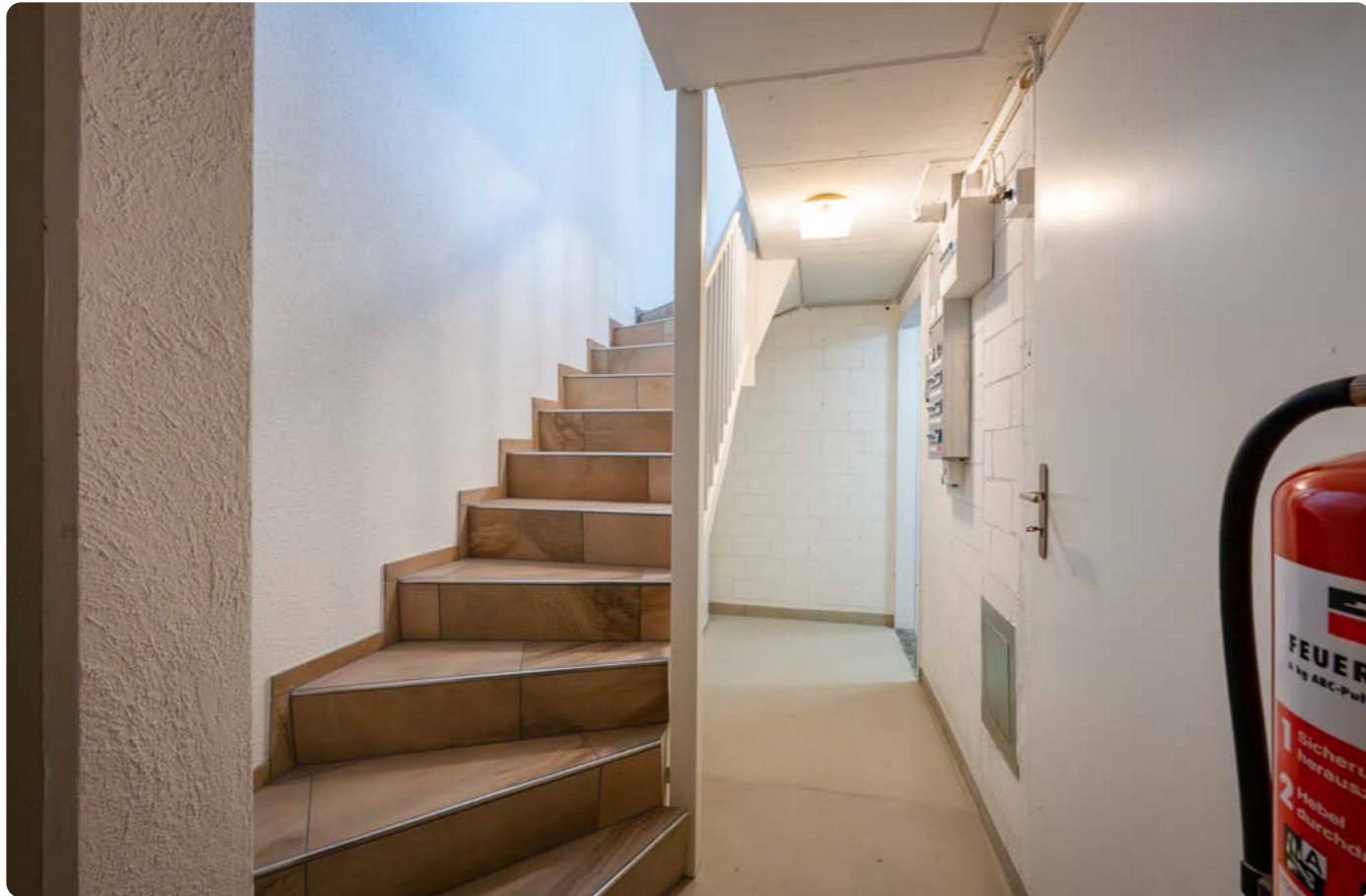
Treppenverbindung ins Untergeschoss
