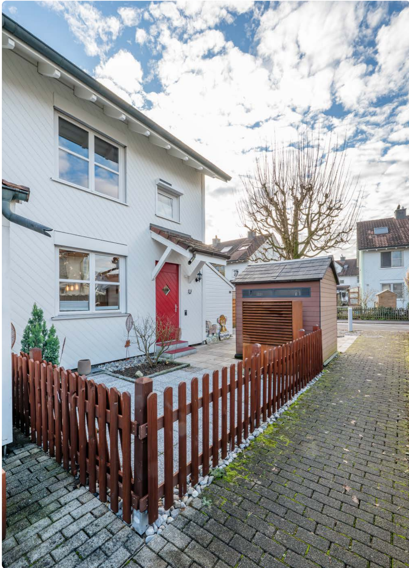
Hauseingangsbereich mit Gartenhäuschen
