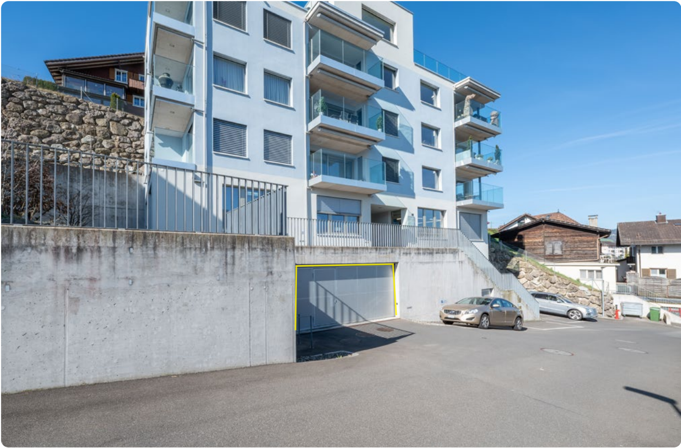
Tiefgaragenzufahrt gleich beim Gebäude
