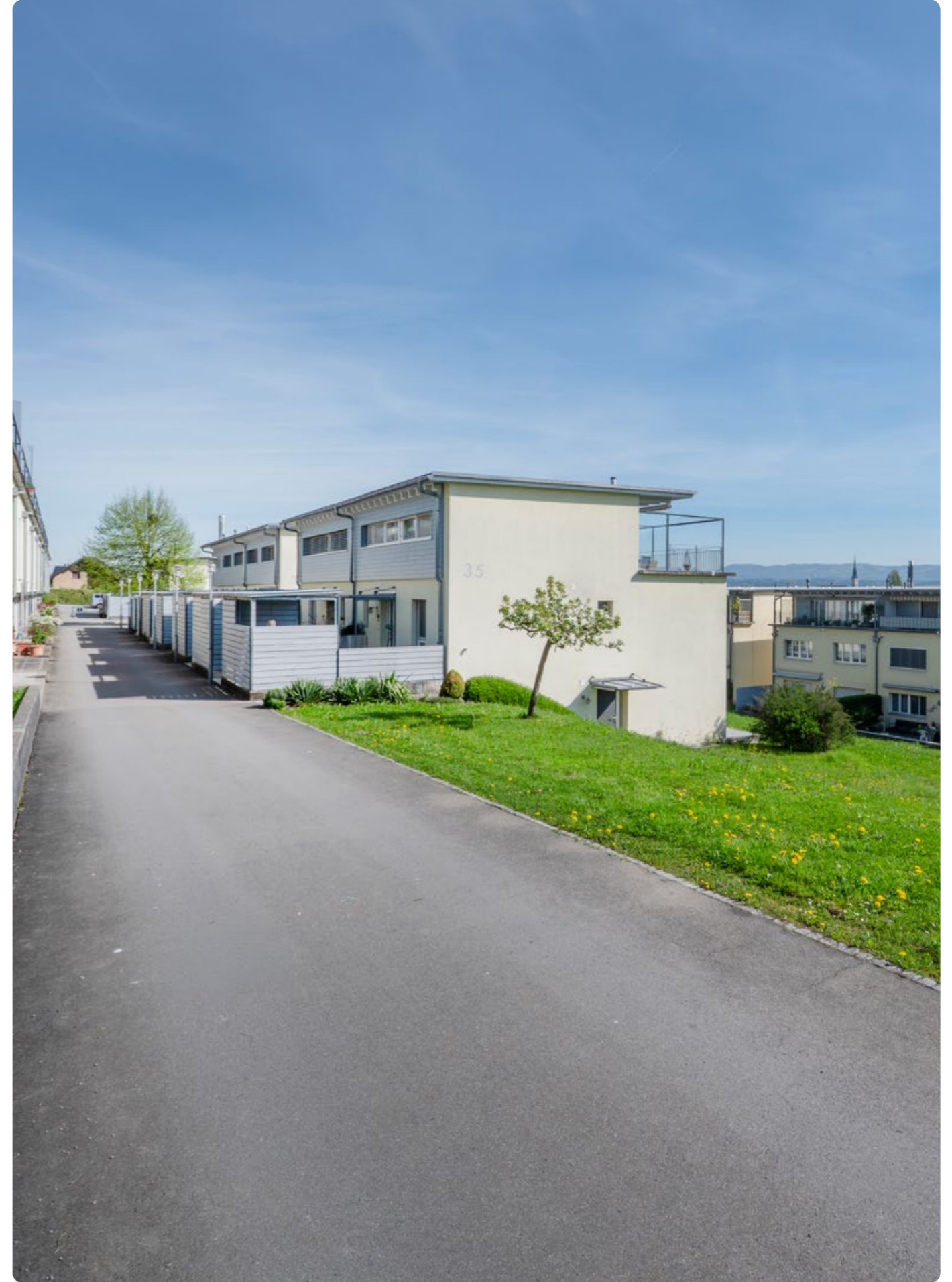
Doppeleinfamilienhaus Nr. 35b
