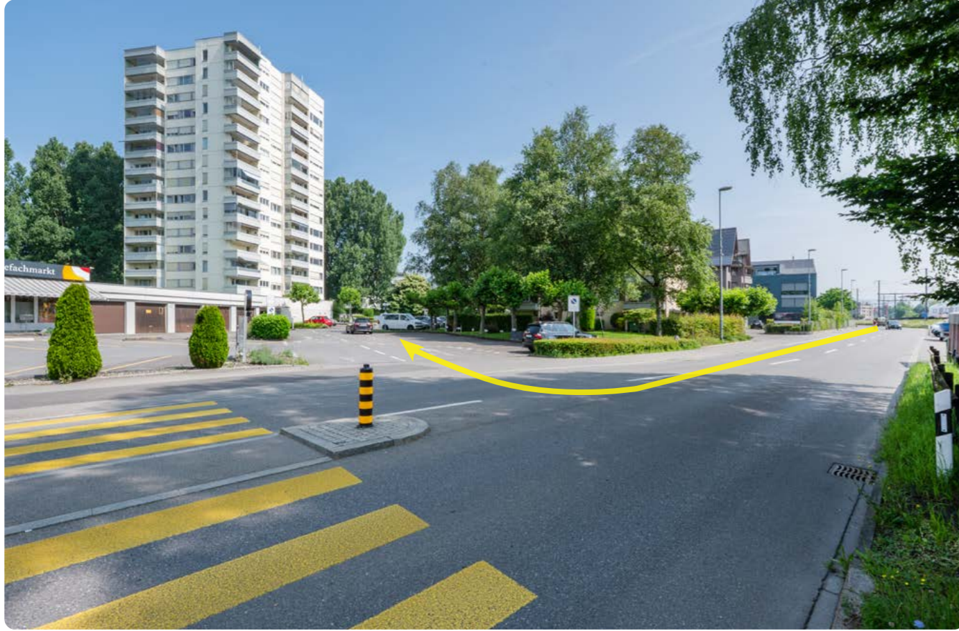
Zufahrt von der Luzernerstrasse
