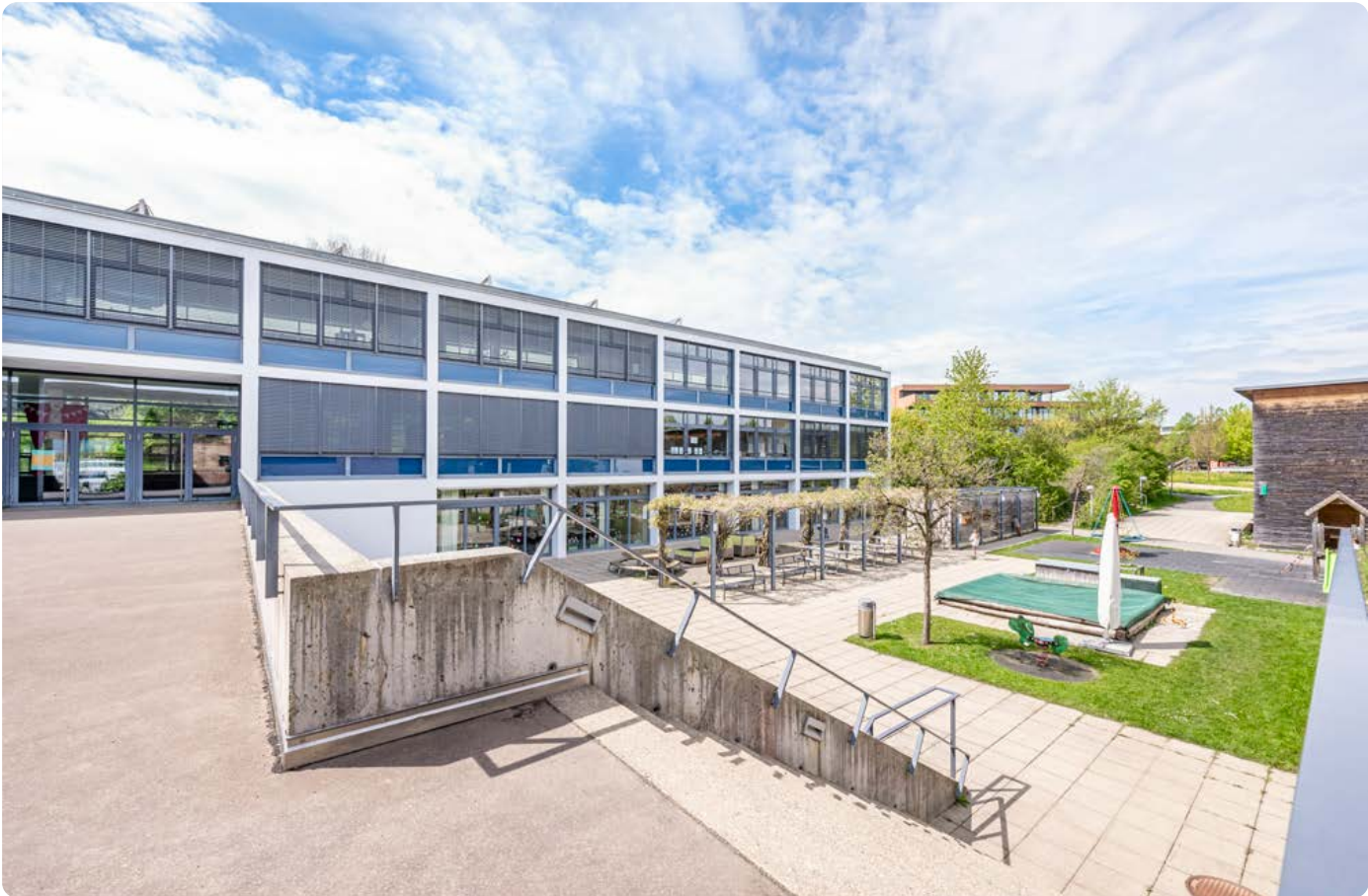
Schulanlage Kemmatten mit Primarschule und Kindergarten
