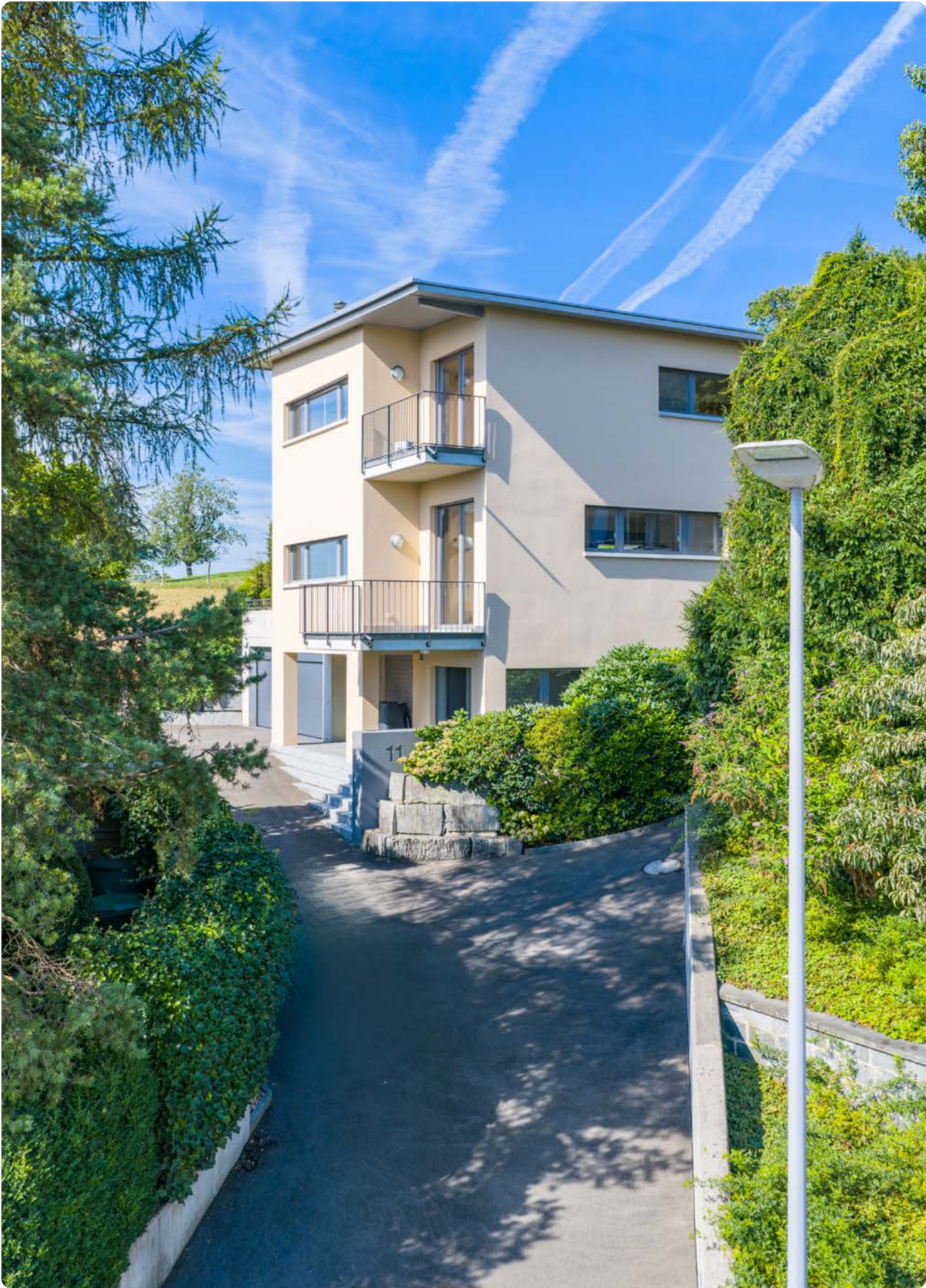
Einfahrt zum Einfamilienhaus
