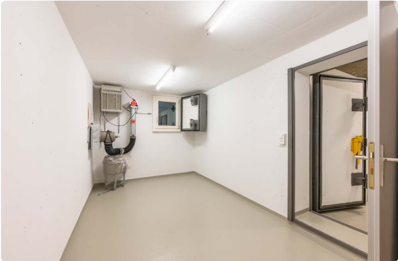
Keller/Schutzraum im Untergeschoss
