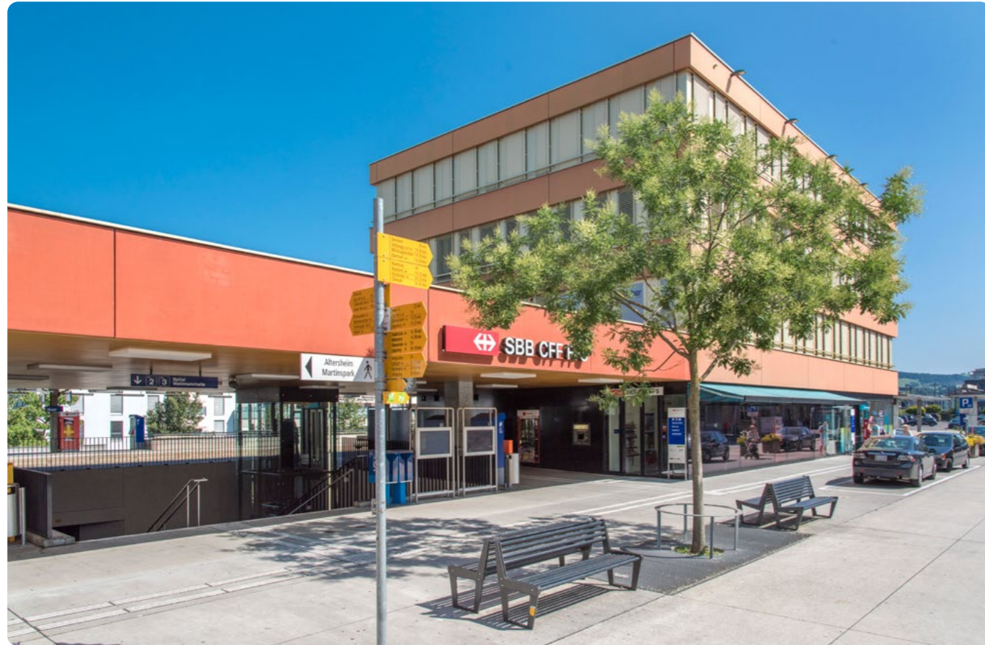
Bahnhof Baar in kurzer Entfernung
