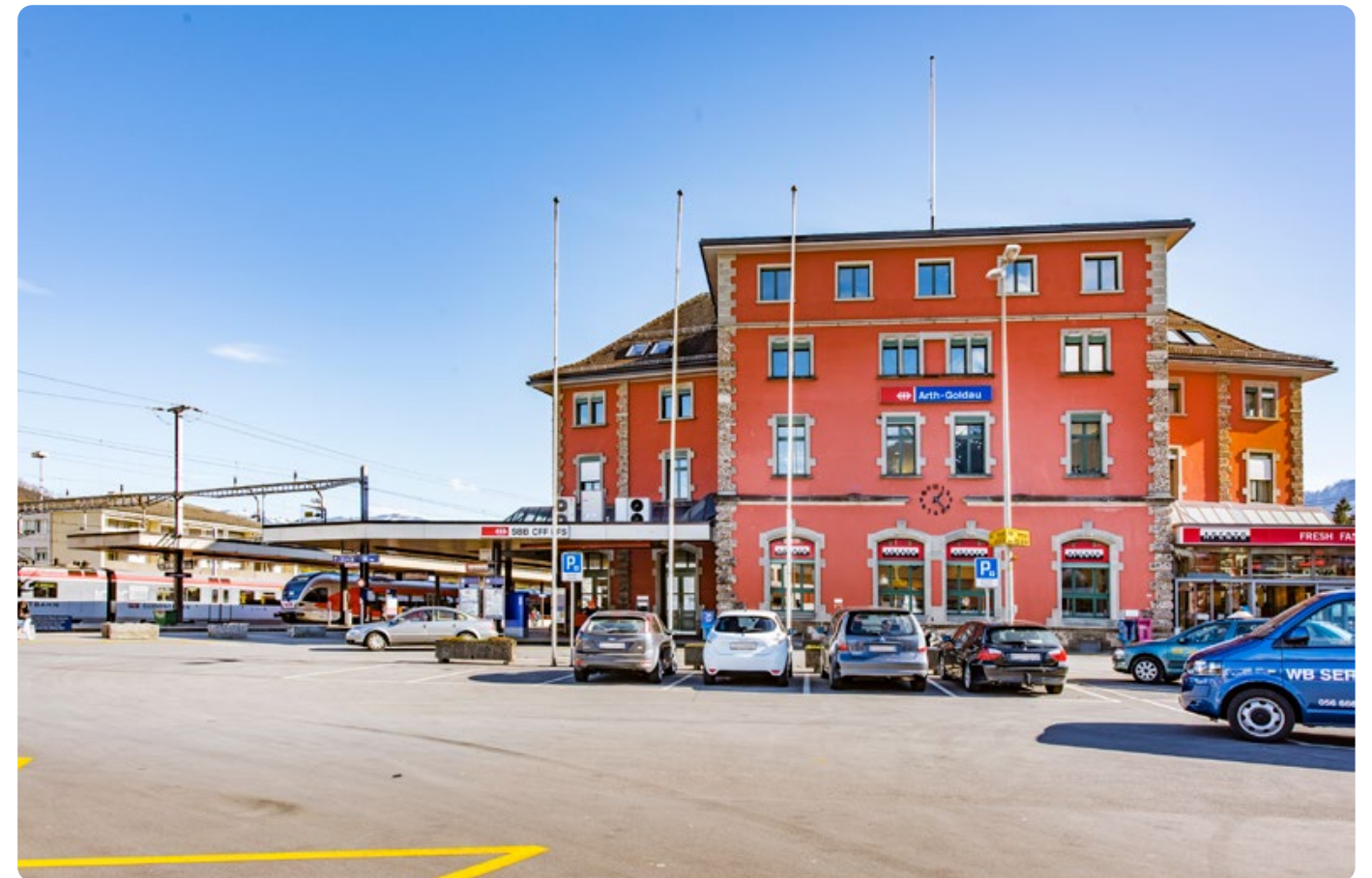
Knotenpunkt Bahnhof Arth-Goldau
