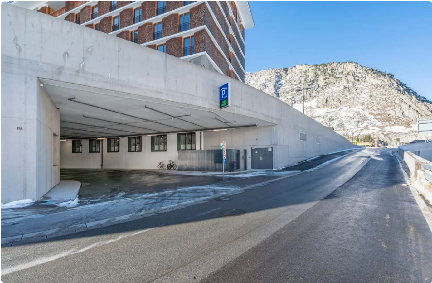
Tiefgarageneinfahrt an der Bärengasse (Radisson)
