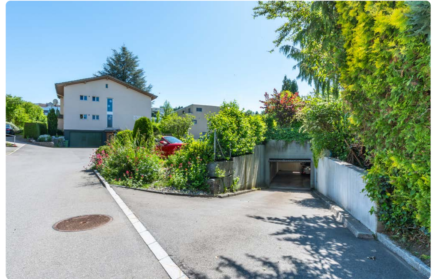
Tiefgarageneinfahrt beim Dorfring 18
